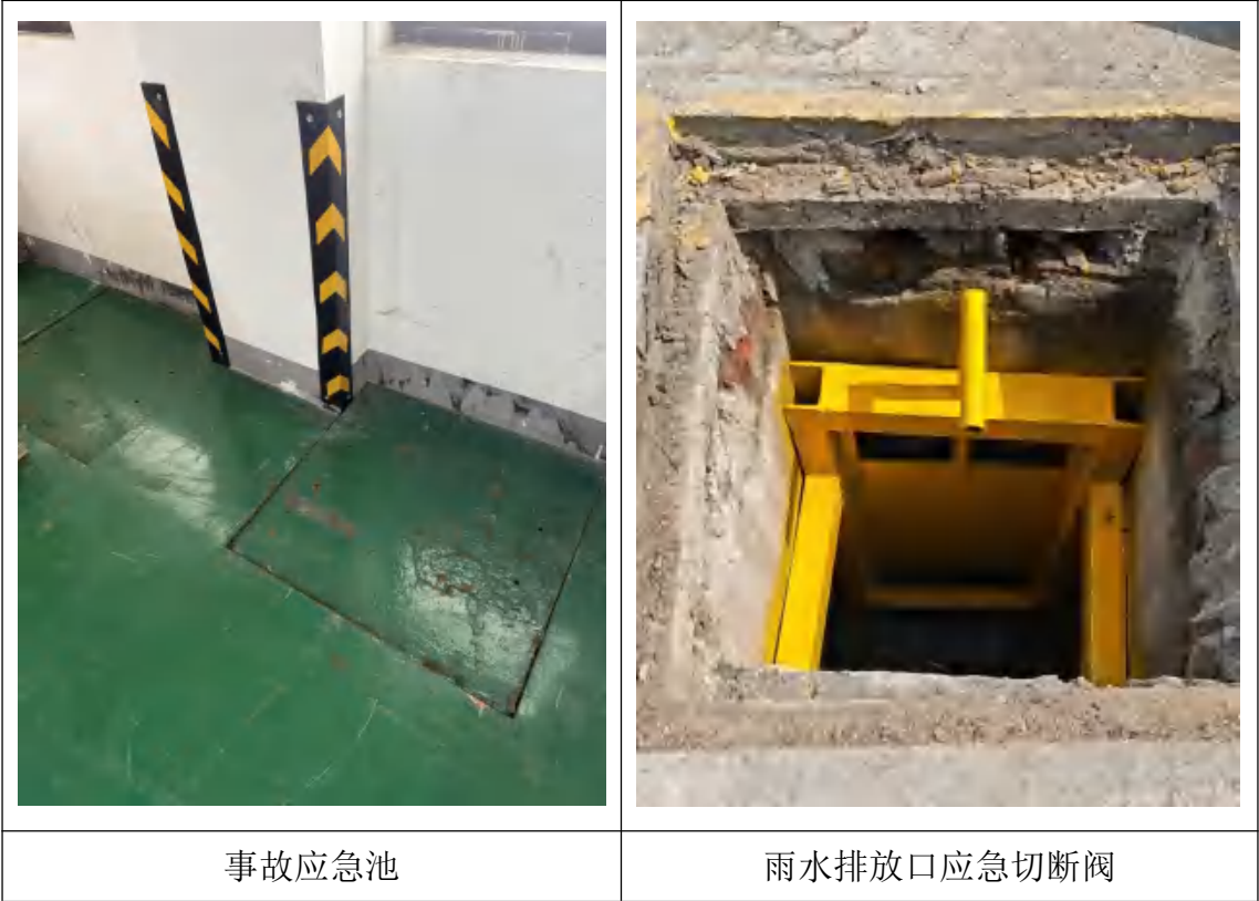
图4.1-3 应急池和应急切断阀现状图
