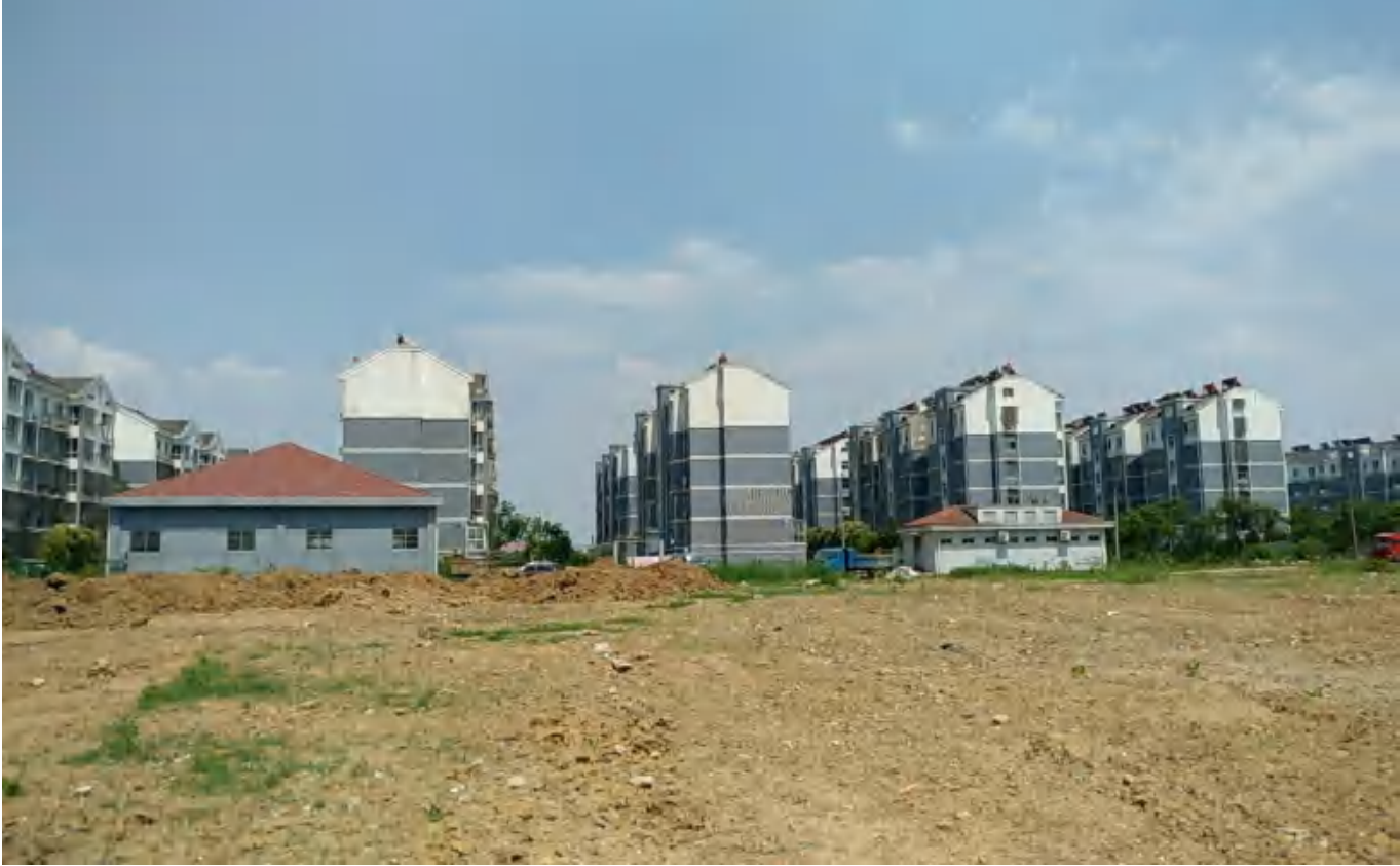
地下室东侧现状：
