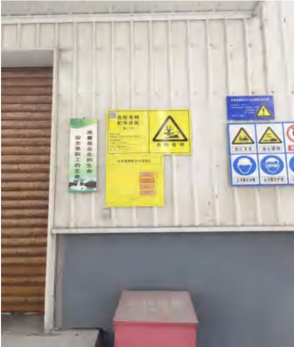
贮存间（危废仓库）外部情况
