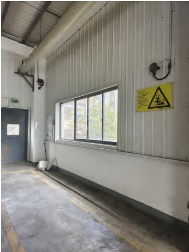
地面硬化，有环氧地坪，负压收集系统
