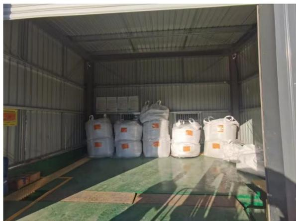
仓库内设有环氧地坪、导流沟、收集池、监控等，符合《危险废物贮存污染控制标准》（GB 18597—2023）中相关要求
