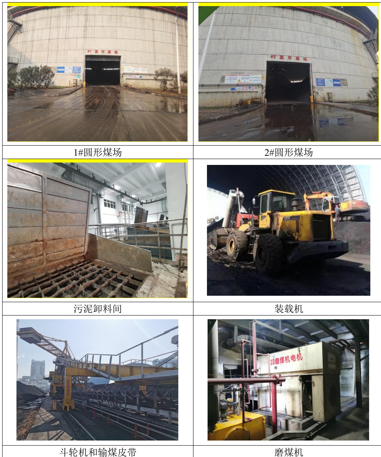
图 7.2-5 沙洲电力污泥干化掺烧发电项目现场照片
