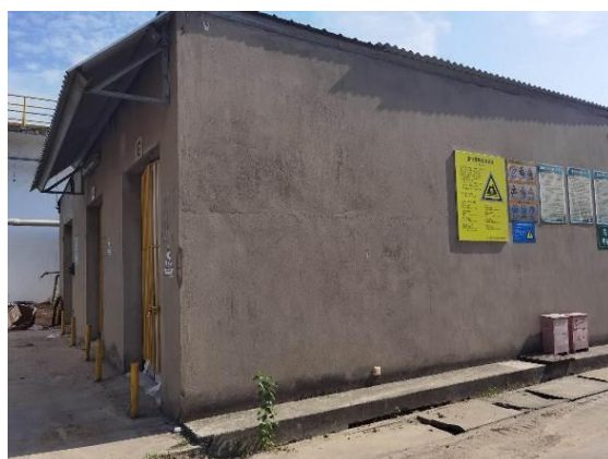
危废暂存库照片
