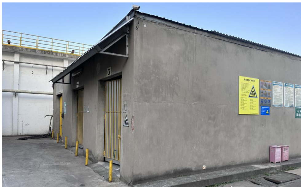
图4.1-6 危废仓库现场照片
