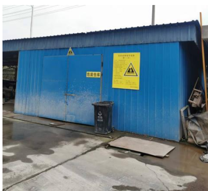
危废贮存设施
