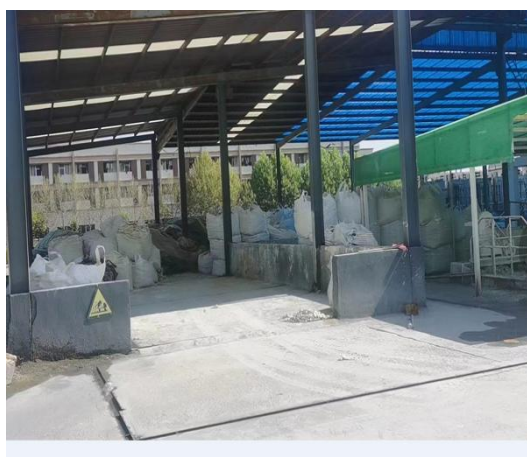
一般固废贮存区域
