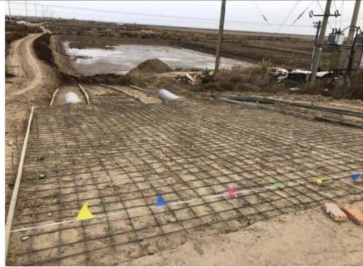
海堤段两侧护坡处理
