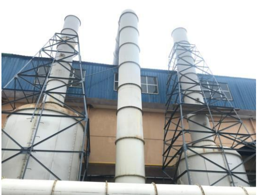
酸雾吸收塔经过改造架空减少渗漏风险
