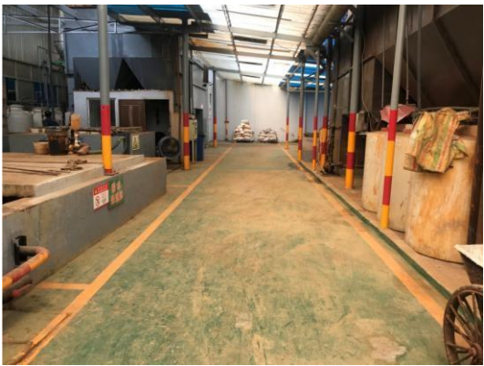
池体表面水泥封盖及防渗膜
