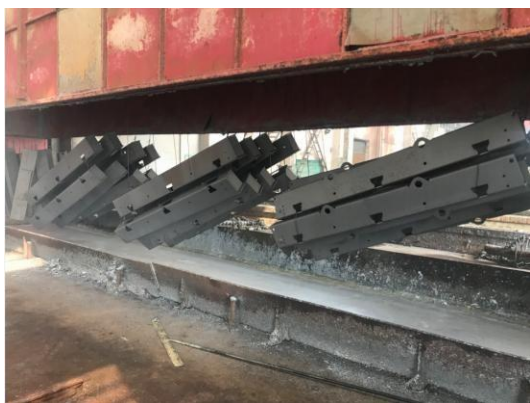
生产车间热镀锌锅现场
