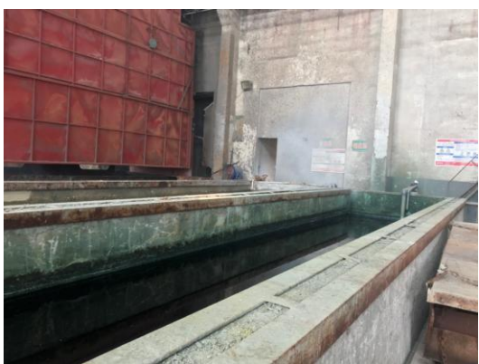
水洗池周边有围堰
