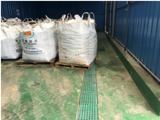
危险废物暂存仓库
