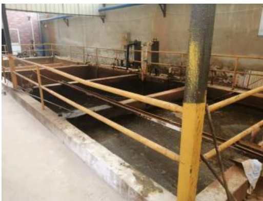
地埋式污水收集防渗池体
