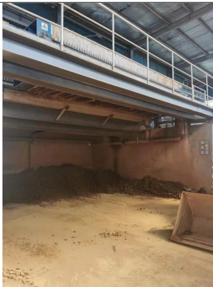
栅渣、污泥堆放场所
