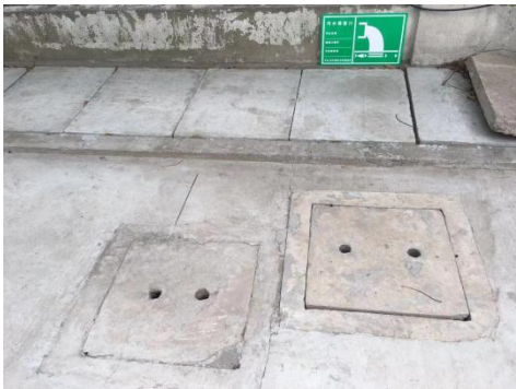
图5-1 生活污水接管口照片
